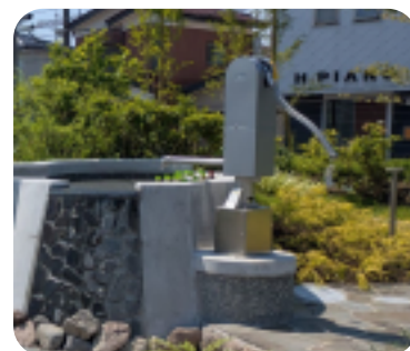
防災用手押しポンプ (みやど公園)
