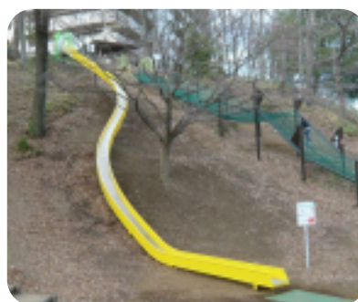
遊具の改修 (島の上公園のロング滑り台)
