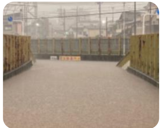
ゲリラ豪雨による浸水被害 (本町 1 丁目/令和 6 年 7 月)
