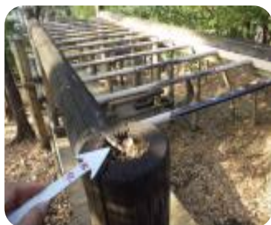
遊具の保守点検の実施
