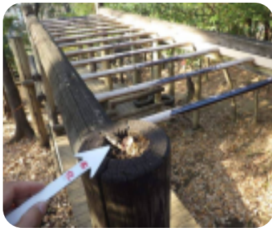
遊具の保守点検の実施
