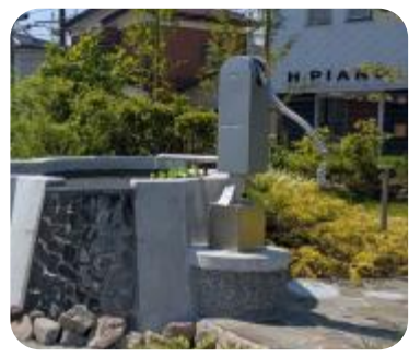
防災用手押しポンプ (みやど公園)
