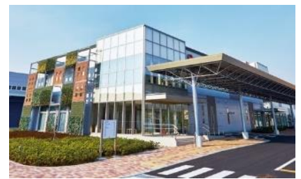
環境配慮型の建物
