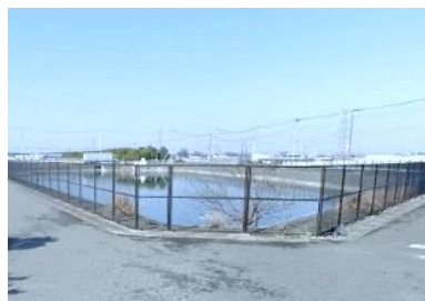
雨水貯留施設の設置
