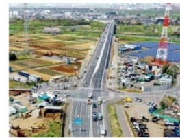
広い幅員の道路（朝霞市内）
