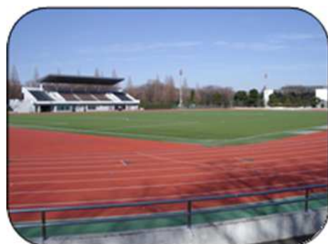
中央公園陸上競技場
