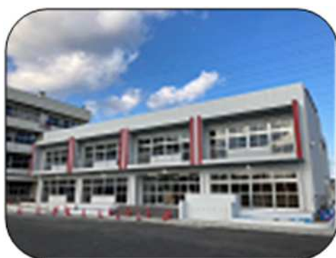
第九小学校増築校舎
