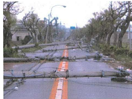
図 台風で倒壊した電柱により道路を塞いでいる様子 (出典：国土交通省)
