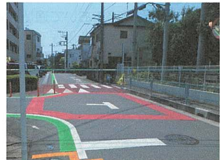
図 スムース横断歩道の設置事例 (朝霞市東弁財地区)
