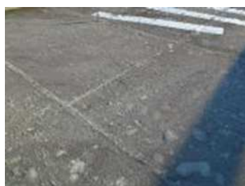
屋根防水の劣化
