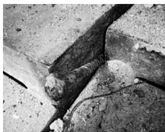
↑焼却炉内の火格子に挟まるボルト
