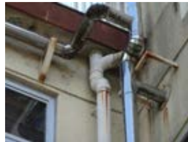
配管接合部の劣化
