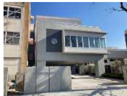
増築校舎全景
