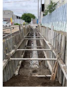
雨水管敷設工事
