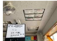
第三中学校4階普通教室天井断熱材設置工事
