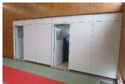
第二中学校柔道場パーティション改修工事
