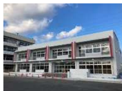
増築校舎全景
