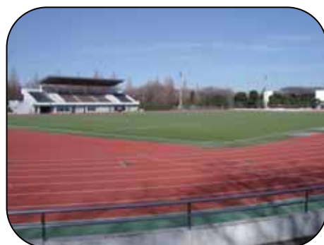
中央公園 陸上競技場
