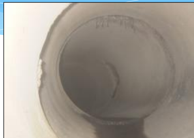
管内に木の根が浸入(閉塞の原因)
