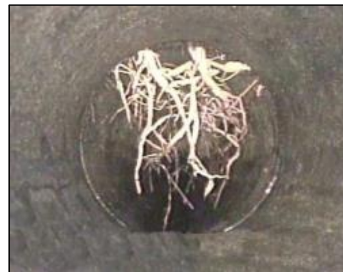
管内に木の根が浸入(閉塞の原因)
