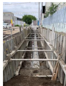
雨水管布設工事
