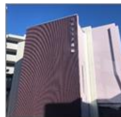
武道館耐震等改修工事
