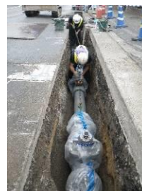
水道管耐震化工事
