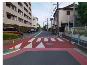
スムーズ横断歩道の設置
