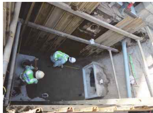
【雨水浸水対策工事】
