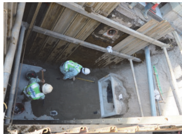
【雨水浸水対策工事】
