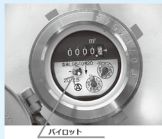
水道メーター
