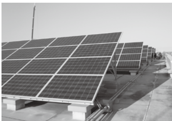
▲屋上ソーラー発電装置
