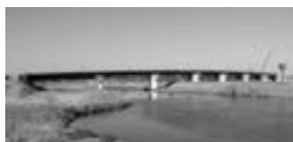
(仮称)朝霞大橋
