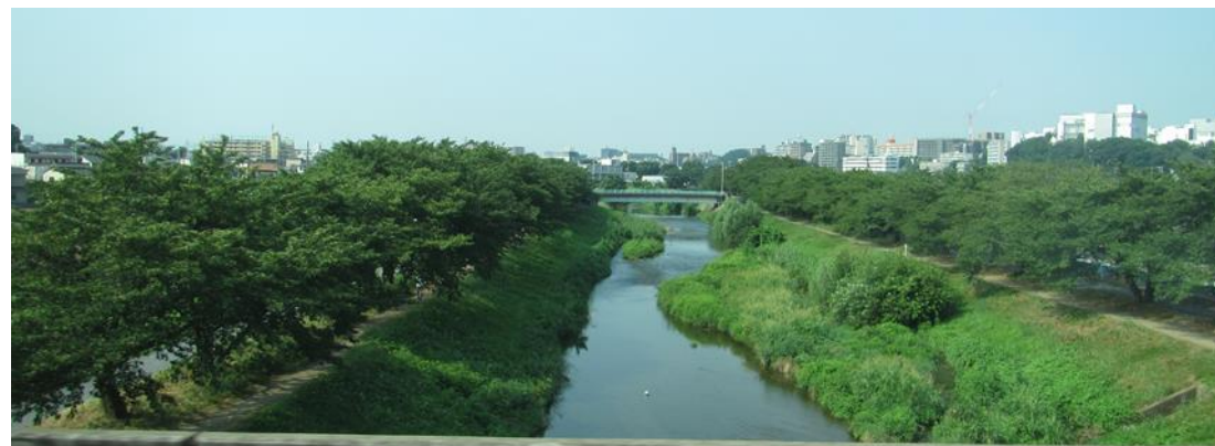
東武東上線の車窓から黒目川上流を望む
