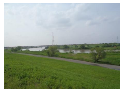
荒川堤防 (大字上・下内間木)
