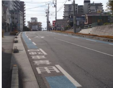
観音通線（自転車道）
