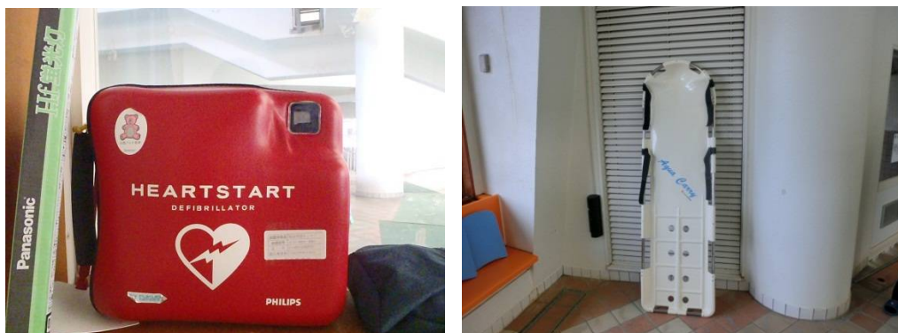
監視室内AED及び採暖室脇水中担架(PT撮影)
